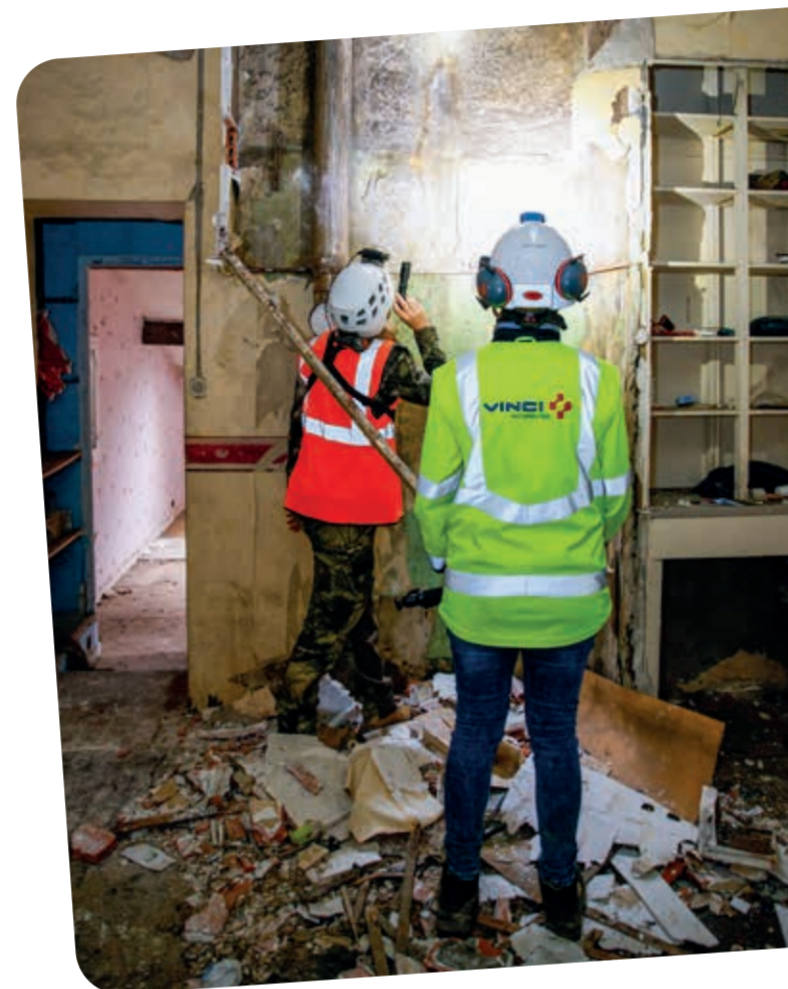
Inspection de la présence des chiroptères dans les bâtis avant démolition.
