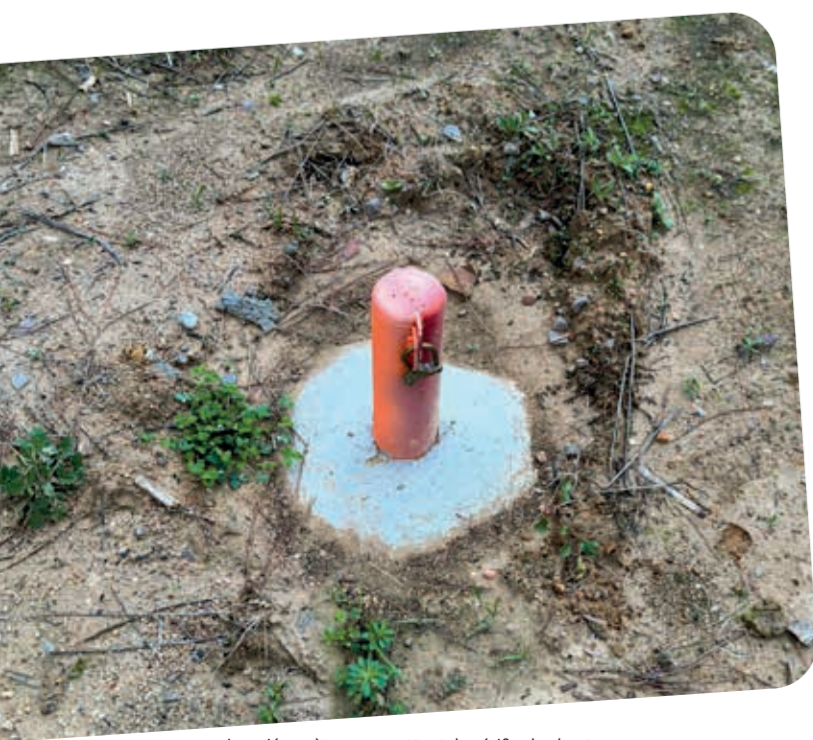
Les piézomètres permettent de vérifier les hauteurs de nappe tout au long des travaux.
